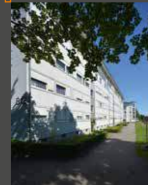
Erfolgreich saniertes Bestandsobjekt in Bietigheim-Bissingen, Primelweg 2-8
