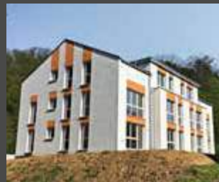
Obdachlosen- und Flüchtlingsanschlussunterbringung in der Grünwiesenstr. 87 in Bietigheim-Bissingen kurz vor Fertigstellung
